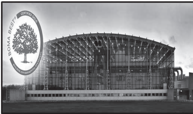
Figura 1 :Centro de Preservação da Biblioteca e Arquivos do Canadá, Quebec
